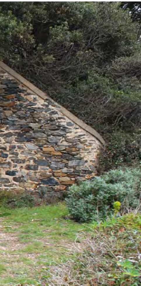
Les ruines de la maison de la Treille.
