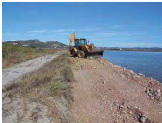
Confortement de la digue Ouest des Pesquiers au droit l'étang Sud ↓
