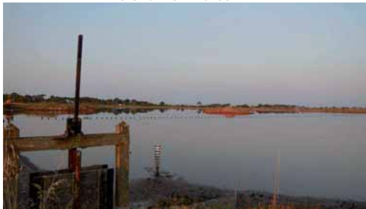
Le chantier finalisé ↓
