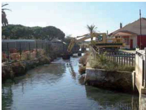
← Désensablement de l'entrée du canal de ceinture
