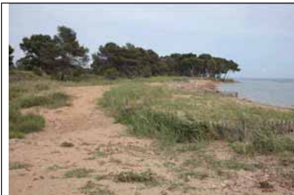
↑ La « griffe d'érosion » en aval des enrochements par rapport au transit hydrosédimentaire
