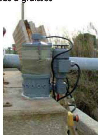
La remise en état des pompes à graisses
