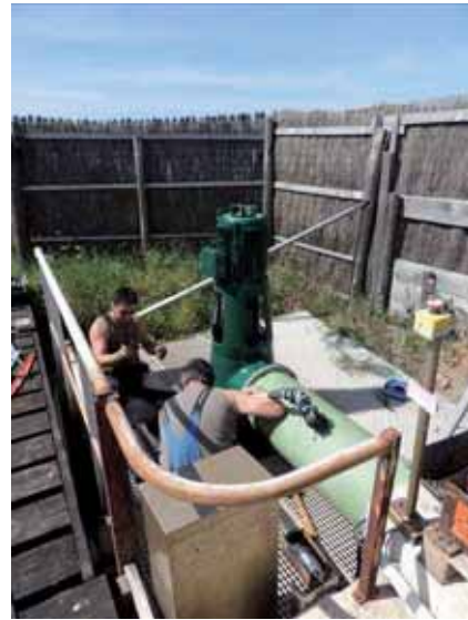
La reprise de l'étanchéité du cuvon
