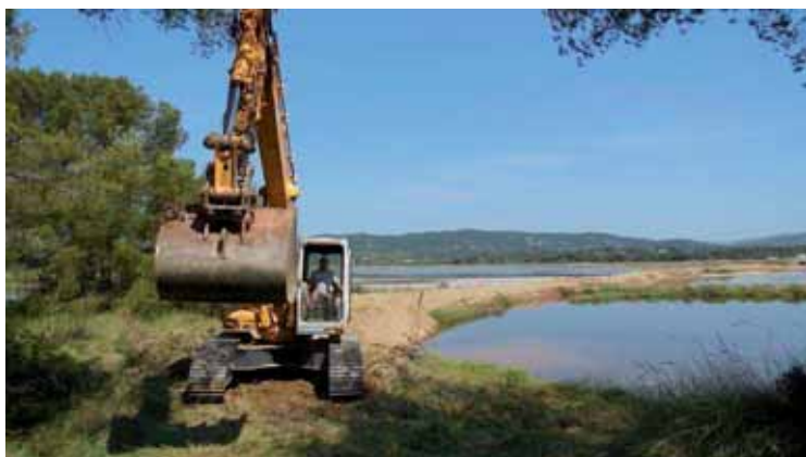
Finalisation de digue de séparation (FABRE)
