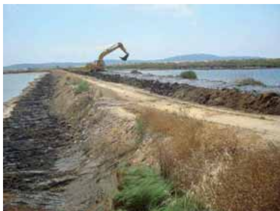
Confortement de la digue Ouest des Pesquiers au droit l'étang Sud ↓
