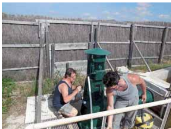
↑ Visite des installations de pompage : l'équipe MICHELIER à pied d'œuvre
