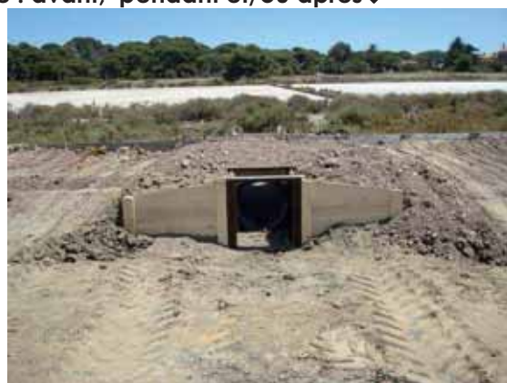
La réfection des ouvrages de vidange : avant, pendant et/ou après↓
