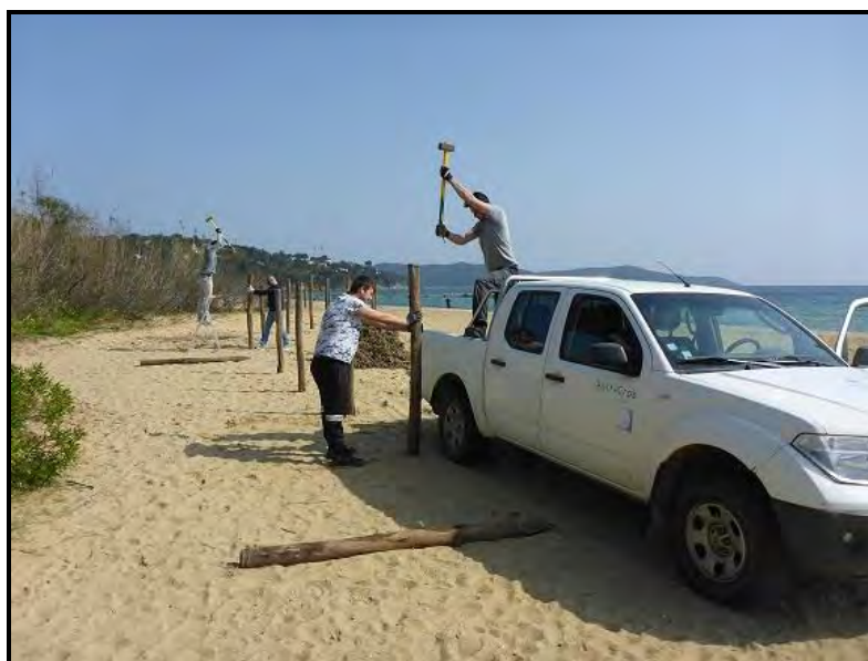
Installation de ganivelles sur la plage du débarquement.
