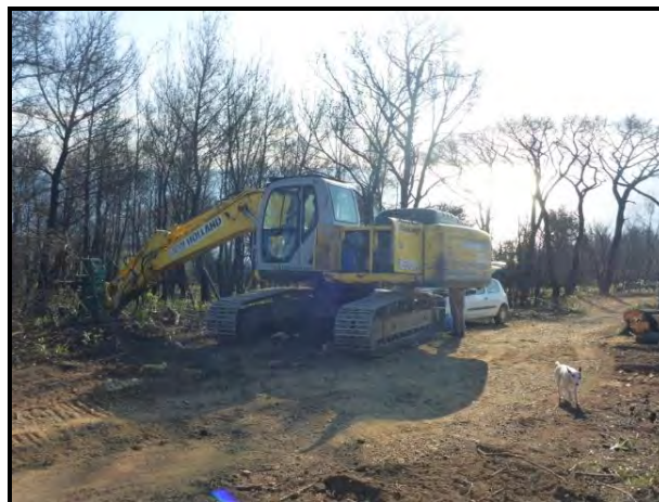
Chantier d'abattage « Max Forest »
