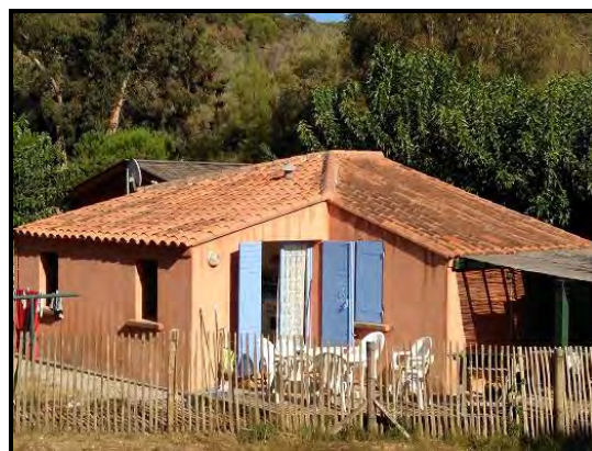
Toiture avant travaux
