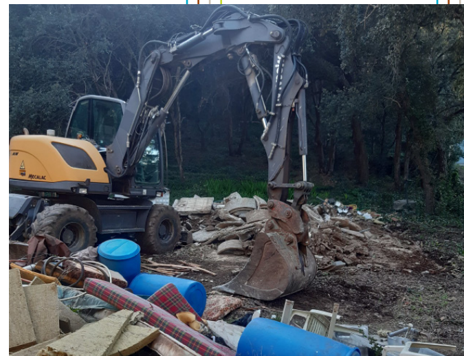
Pendant les travaux
