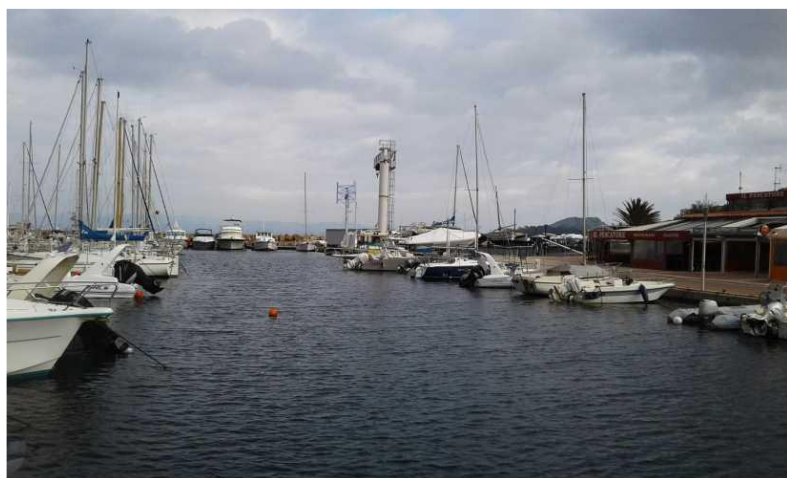
Con l'impianto eolico installato
