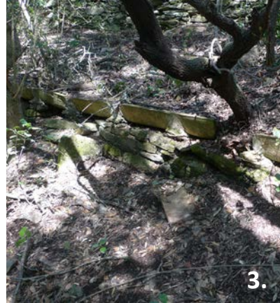
3. Restanque et sa canalette, vestige de l'aménagement hydraulique du territoire
