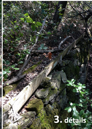
3. Restanque et sa canalette, vestige de l'aménagement hydraulique du territoire
