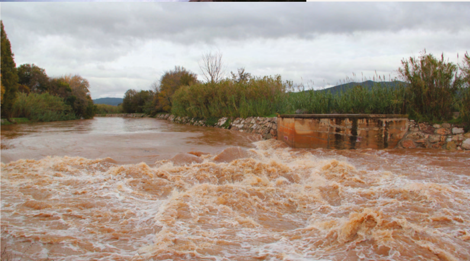
Figure 7 : Le Gapeau en crue (Source C. Gérardin).
