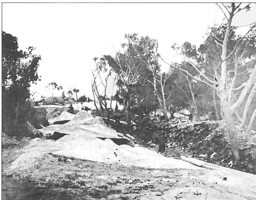
Fig. 3 - Tranchée de la voie Decauville entre les pièces n°3 et 2. On peut apprécier le camouflage en treillage céramique qui recouvre la tranchée, avant son raccordement avec le terrain alentour. On aperçoit à l'arrière-plan la pièce n°2. Service historique de la Marine - Vincennes)
