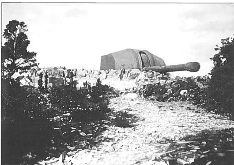
Fig. 2 - Pièce n°3. Le canon de 164 avec son masque en tôle. On distingue parfaitement le camouflage en enrochement. (Service Historique de la Marine - Vincennes)
