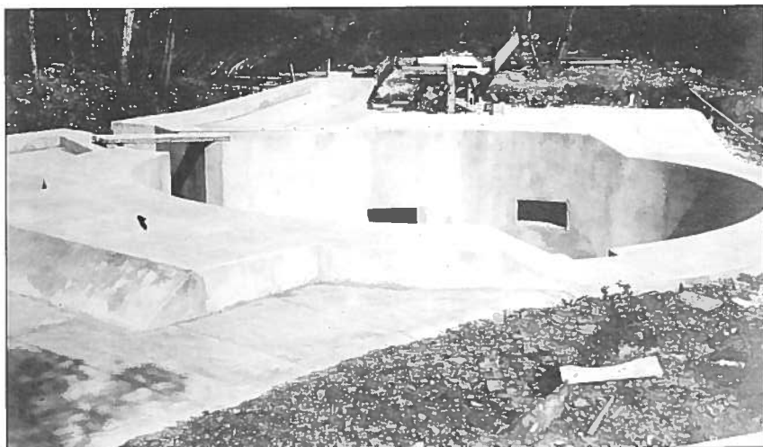
Fig. 1 - Cuve et magasins de la pièce n° 1 en cours de construction. Sont visibles deux des quatre guichets d'alimentation de la pièce. Au premier plan, la dalle de couverture d'un des deux magasins à munitions. (Collection J.-F. Roudier)
